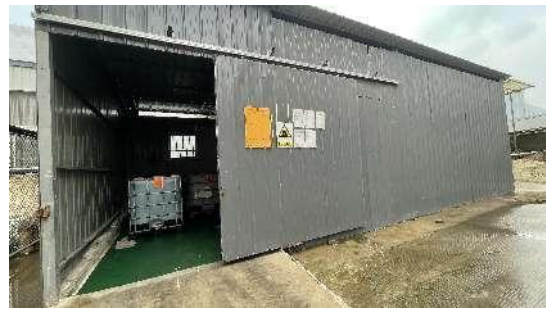
依托已验收的危废暂存仓库（废槽液）
